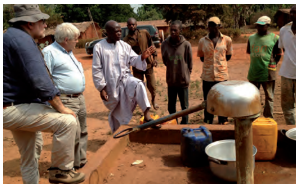
Réhabilitation d'un puit et forage avec pompe manuelle au Cameroun.
