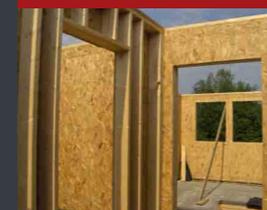
C'est la technologie la plus employée aujourd'hui. Elle permet une construction légère, rapide, variée et peu coûteuse. Les pans de mur peuvent être fabriqués en atelier et supportent tous types de revêtements intérieurs et extérieurs.
