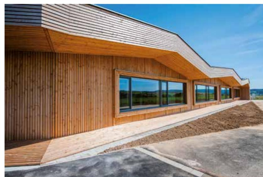
*Un bâtiment exemplaire par sa taille et par la mise en œuvre de bois issus de la forêt communale avec des éléments en lamellé collé.*
