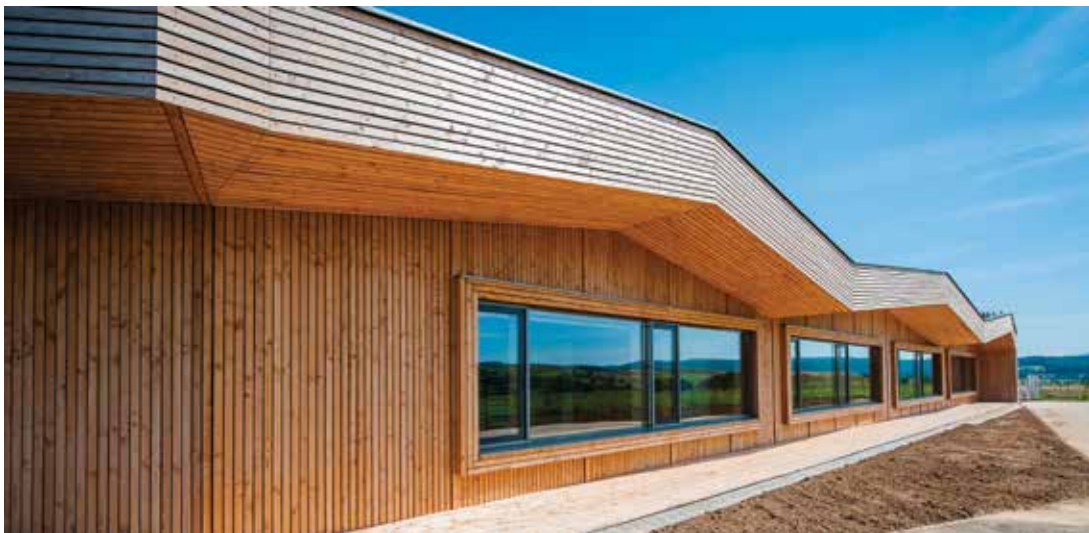
Groupe scolaire de Hadol (88) / Architecte : SARL LARCHE-METZGER (Photo : Marc Philippe)
