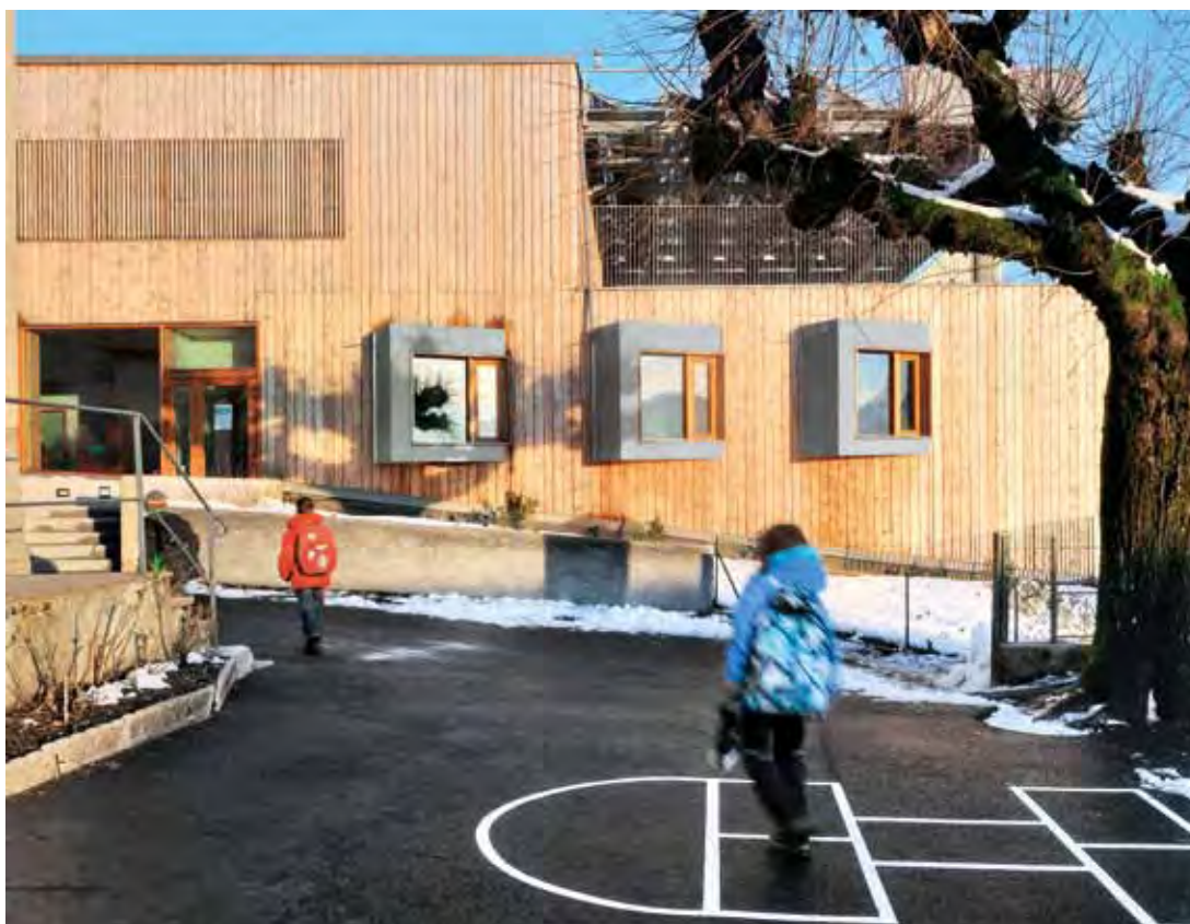
Les bureaux de la mairie, orientés à l'ouest, captent le soleil du sud par des bow-windows.
