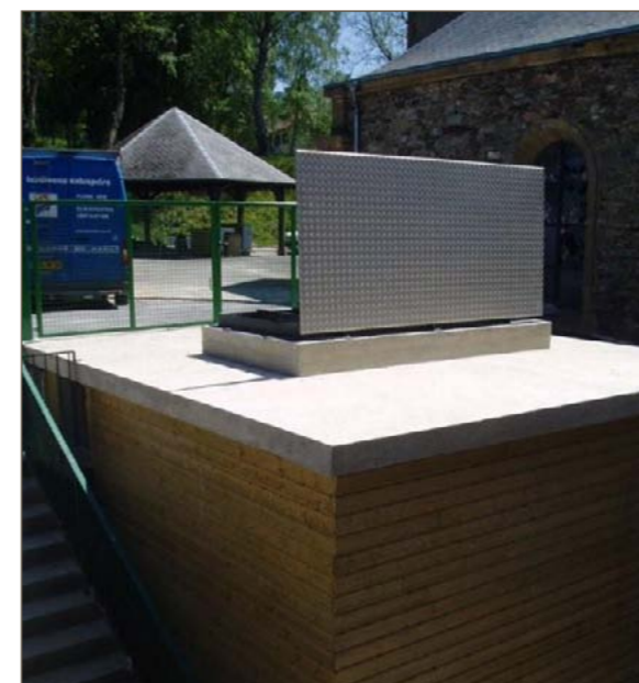
La commune forestière de Sécheval (France) dispose d'une chaufferie au bois capable de produire une puissance de 55kW. La chaufferie ci-dessus, recouverte d'un bardage bois, est raccordée à un réseau de 85 mètres linéaires de tuyaux enterrés permettant de chauffer la mairie, deux logements et assure le préchauffage de l'église locale. © ALE08
