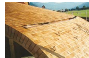
La couverture en tavaillons est une technique particulière au résultat singulier.
