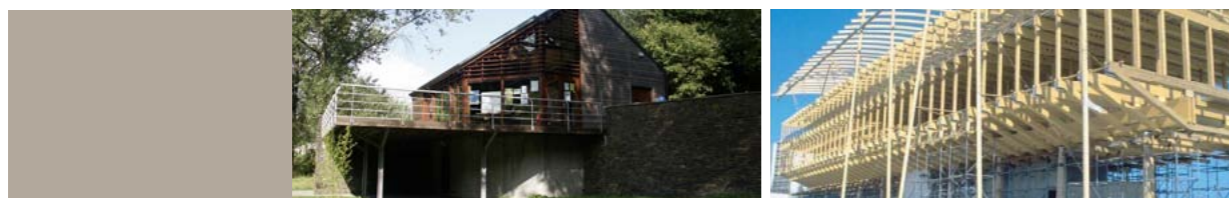
Quoi de mieux que le bois pour réaliser une maison de la pêche en pleine nature telle qu'à Habay-la-Neuve (Wallonie) ? © La Fibre Com
