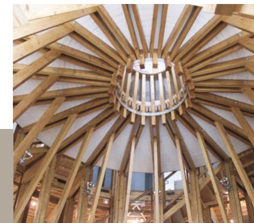
Cette structure particulière en bois habille l'intérieur d'un bureau spécialisé à Waterloo (Wallonie).
